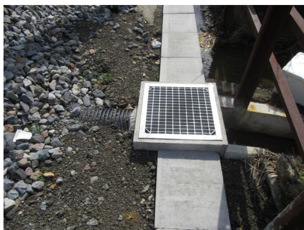
大河端駅～北間駅間 線路側溝新設
