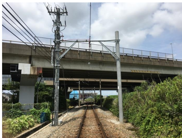
磯部駅～割出駅間 電柱更新
