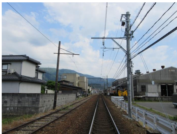
鶴来駅構内 電柱更新
