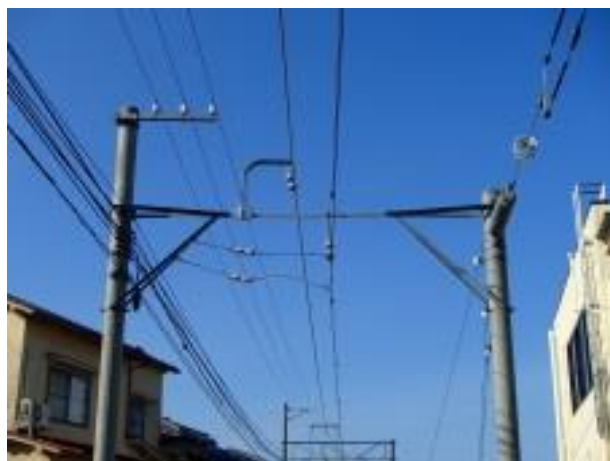
七ツ屋駅～割出駅間 き電線更新
