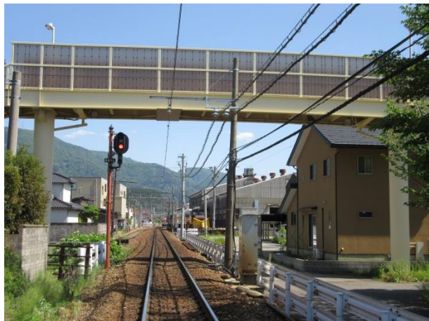
日御子駅～鶴来駅間 配電線更新
