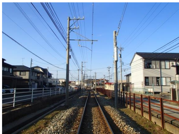
七ツ屋駅～三口駅間 電車線更新
