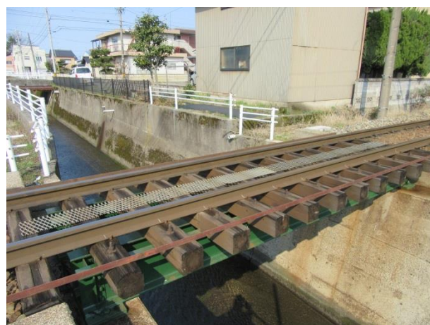
石川線 住吉川橋梁
