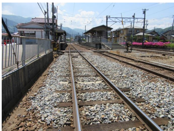
鶴来駅構内 レール・道床交換
