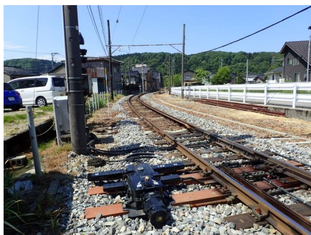
鶴来駅構内 分岐器交換
